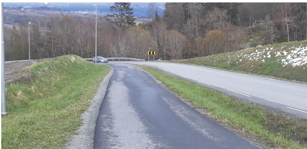
Figur 7: Utsikt i nordgående retning av Fv6644 fra planlagt adkomst til foreslått planområde.
